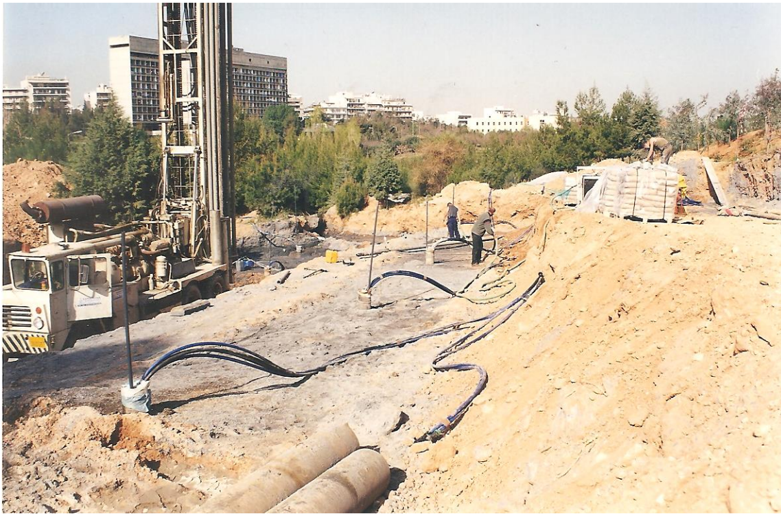
Φωτ. 6. Κατασκευή Γεωθερμικού Πεδίου και τοποθέτηση γεωθερμικών εναλλακτών μέχρι το βάθος των 100 μ. 1999/2000.
