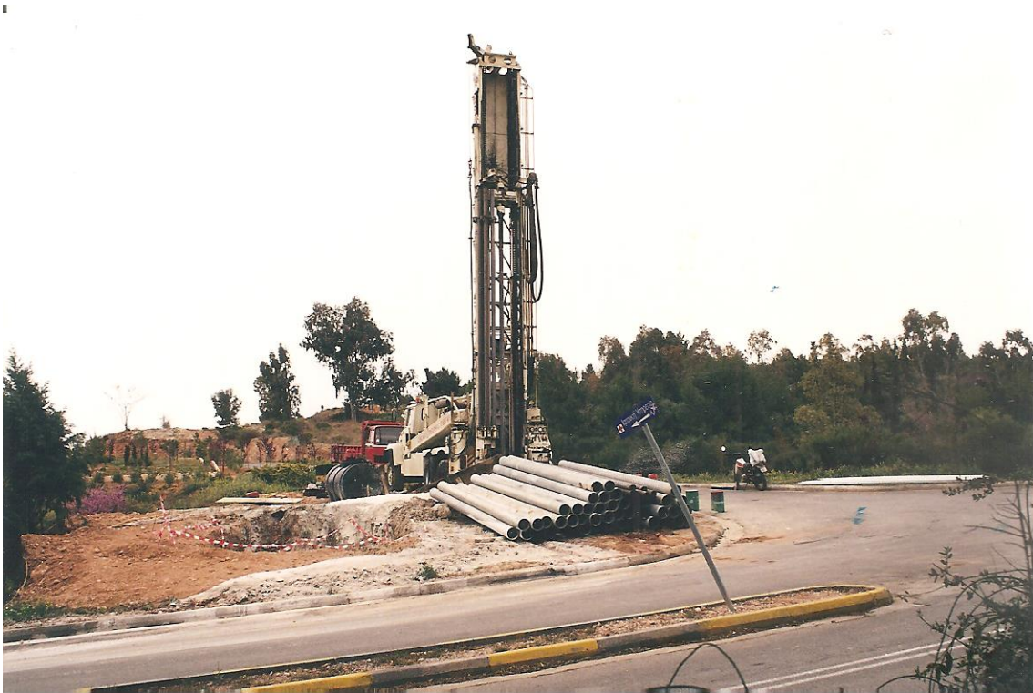
Φωτ. 5. Υδρογεώτρηση 3 η , Πολυτεχν/πολη Ζωγράφου, σχετίζεται με τη Γεωθερμική Μονάδα, 1999.
